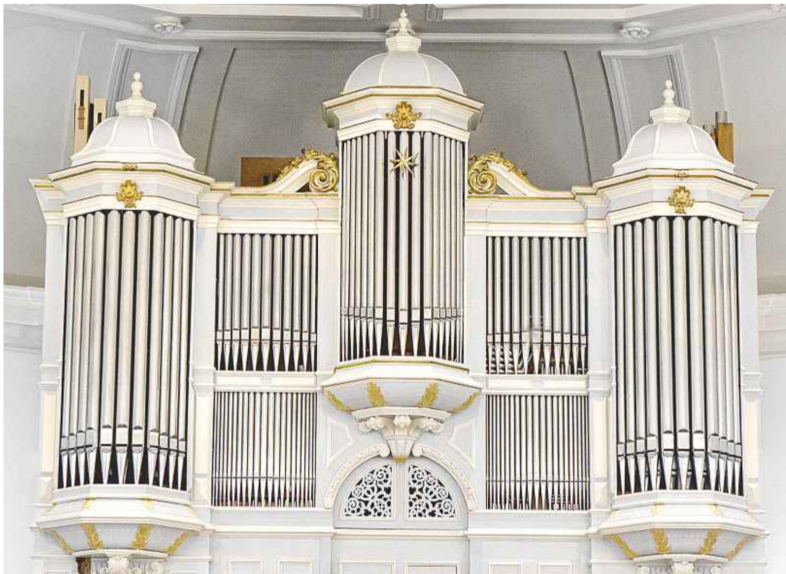
Im Gehäuse versteckt: 3619 Pfeifen, die größte kommt auf sechs Meter, die kleinste misst sechs Millimeter.
