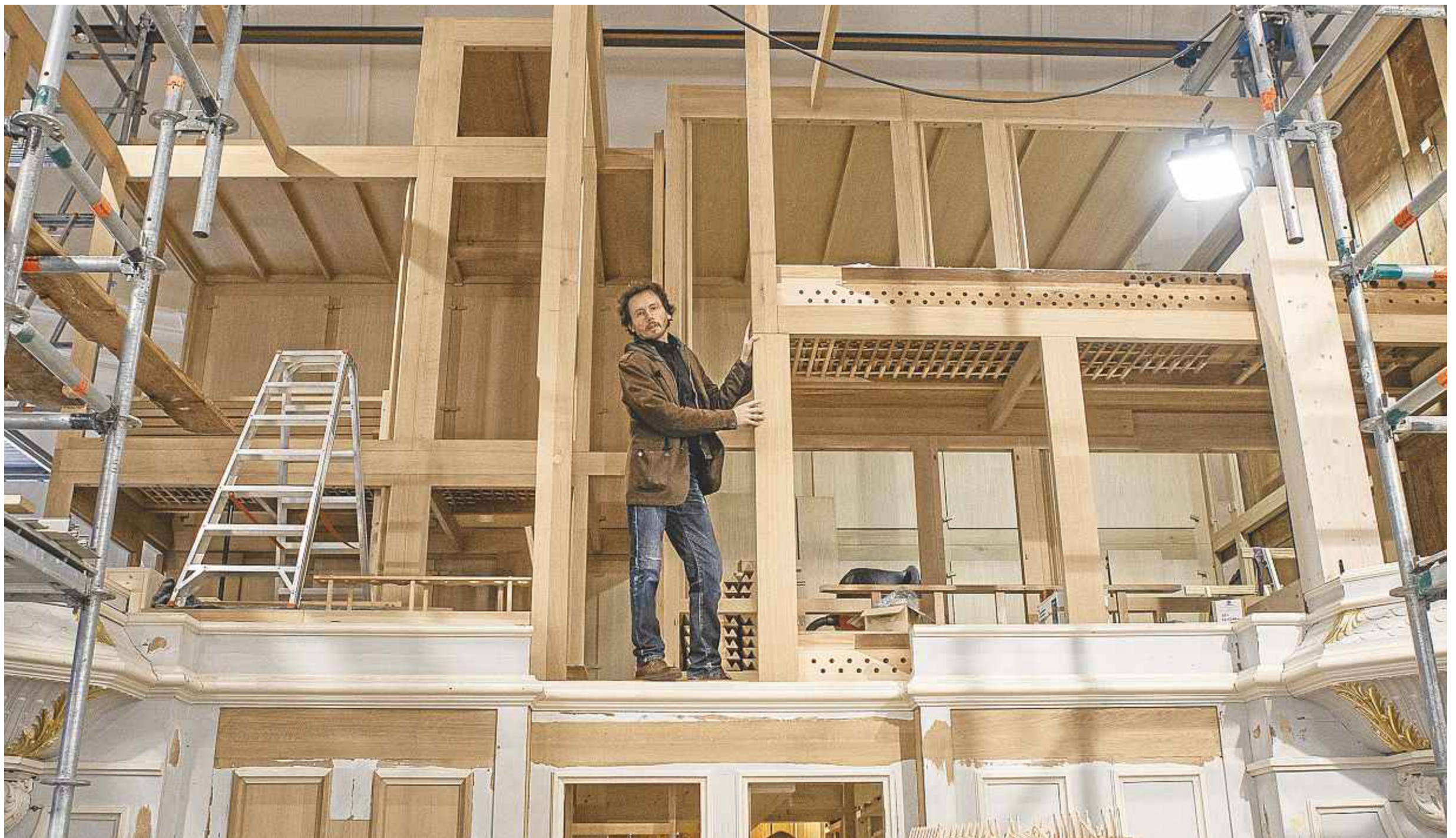
Sieht fast aus wie Hausbau, ist aber das Grundgerüst für die Orgel in der Stadtkirche. Mitten drin der Kantor und Organist Martin Kaleschke. In dieses Gerüst werden Orgelbauer in den kommenden Wochen hunderte von Pfeifen unterschiedlichster Größen einbauen.
