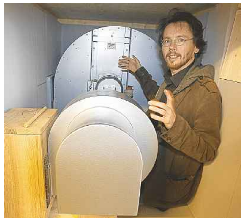
Ein eigenes, schalldichtes Kämmerchen für das Gebläse mit Elektromotor – und sogar noch Platz für Bezirkskantor Martin Kaleschke.
