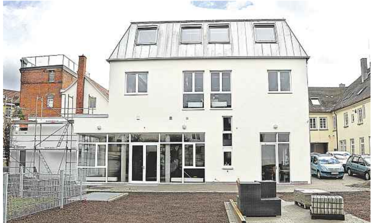
Rückansicht des Gebäudes mit dem zukünftigen Garten.
