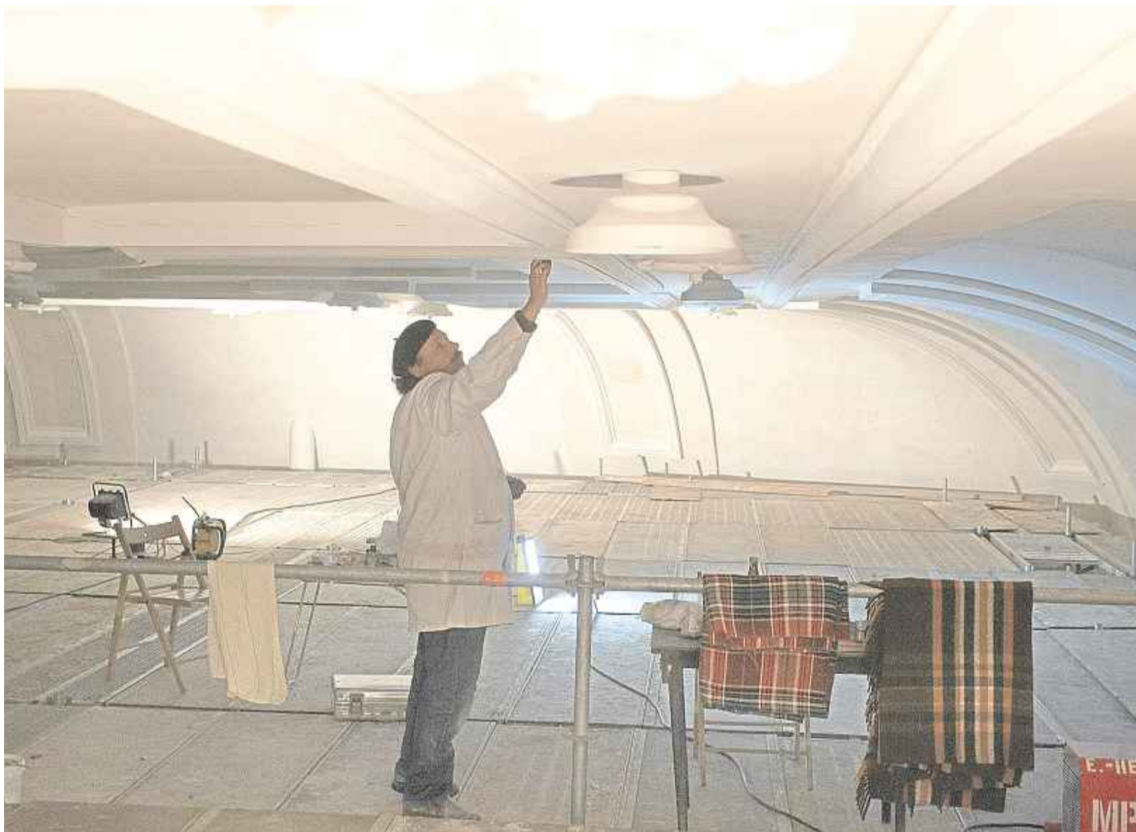
Restaurator Stefan Mäule arbeitet am Deckengewölbe der barocken Stadtkirche in etwa 25 Metern Höhe. Ein Baugerüst macht es möglich.
