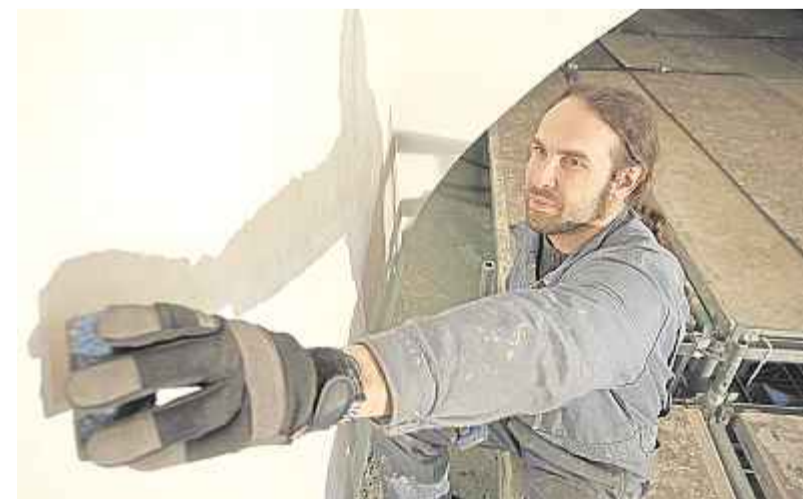
Jan Rademaker reinigt mit einem kleinen Radierer das Deckengewölbe.
