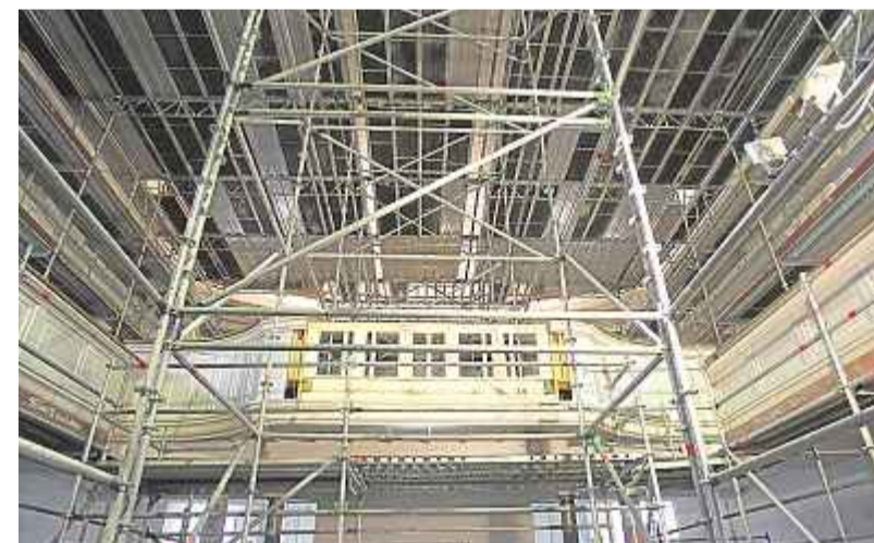
Der Aufbau des Gerüsts hat Wochen gedauert.
