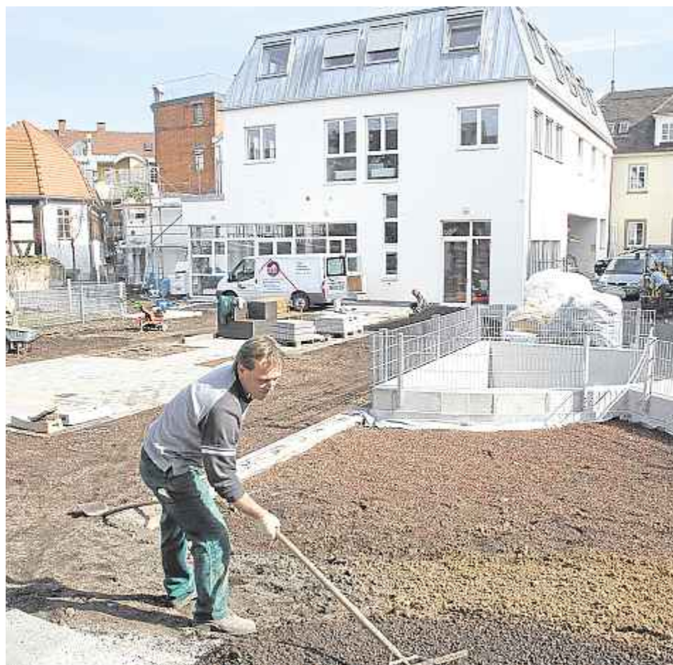
Blick über den Garten im Hinterhof auf den Neubau.
