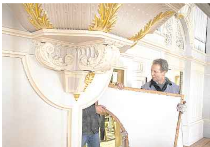
Das Gehäuse der Orgel aus dem Jahr 1889 ist denkmalgeschützt und wird in Bonn aufgearbeitet. Die Empore wird am Ende ganz leer sein. Die Holzpfeifen machen 80 Prozent des Gewichts der Orgel aus und werden größtenteils erhalten.
