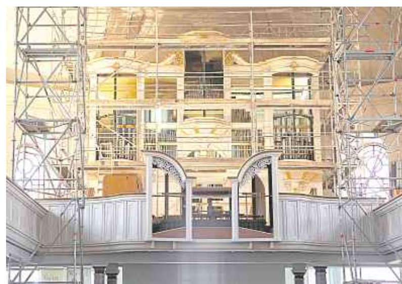
Das Gehäuse der Orgel aus dem Jahr 1889 ist denkmalgeschützt und wird in Bonn aufgearbeitet. Die Empore wird am Ende ganz leer sein. Die Holzpfeifen machen 80 Prozent des Gewichts der Orgel aus und werden größtenteils erhalten.
