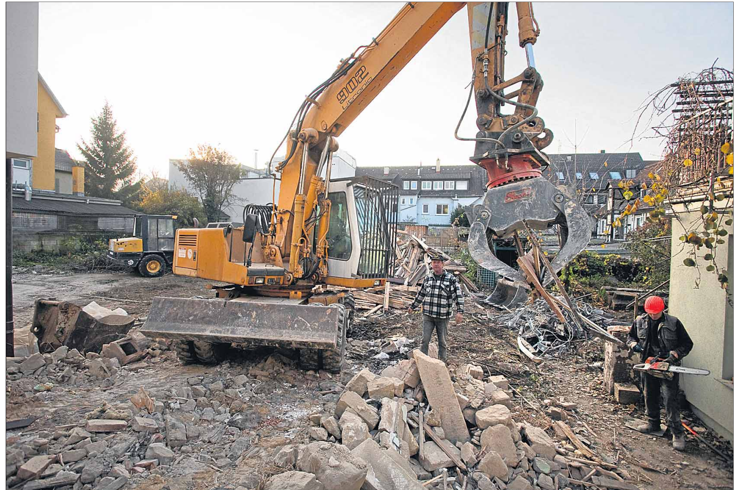
Im großzügigen Innenhof wird eine alte Remise abgebrochen. Wo der Bagger gerade steht, wird künftig der Saal der evangelischen Stadtkirchengemeinde sein. Bild: Benjamin Stollenberg
